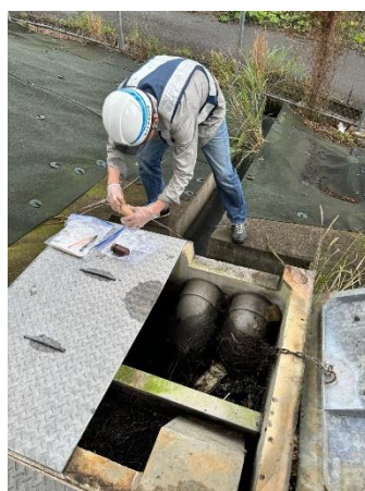
図2. 集水桝での調査
